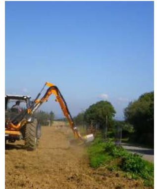
Débroussaillage des flancs de talus à l'épaveuse (photo : EPAGA).
